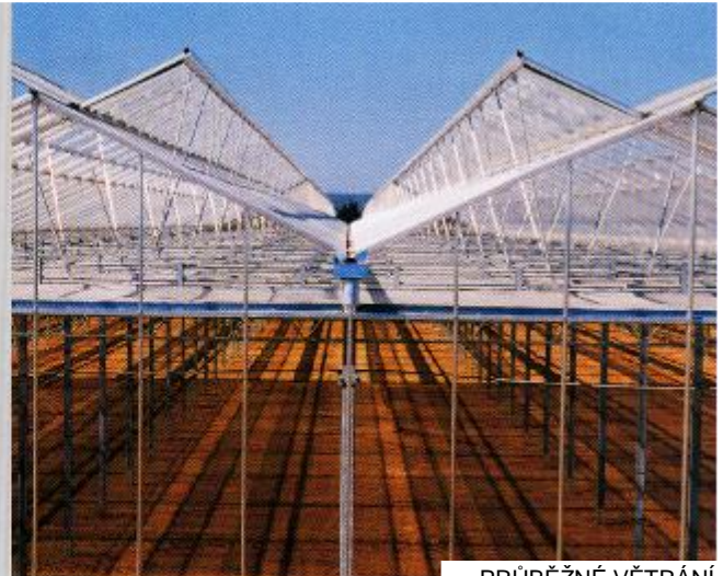
PRŮBĚŽNÉ VĚTRÁNÍ Continuous vents
